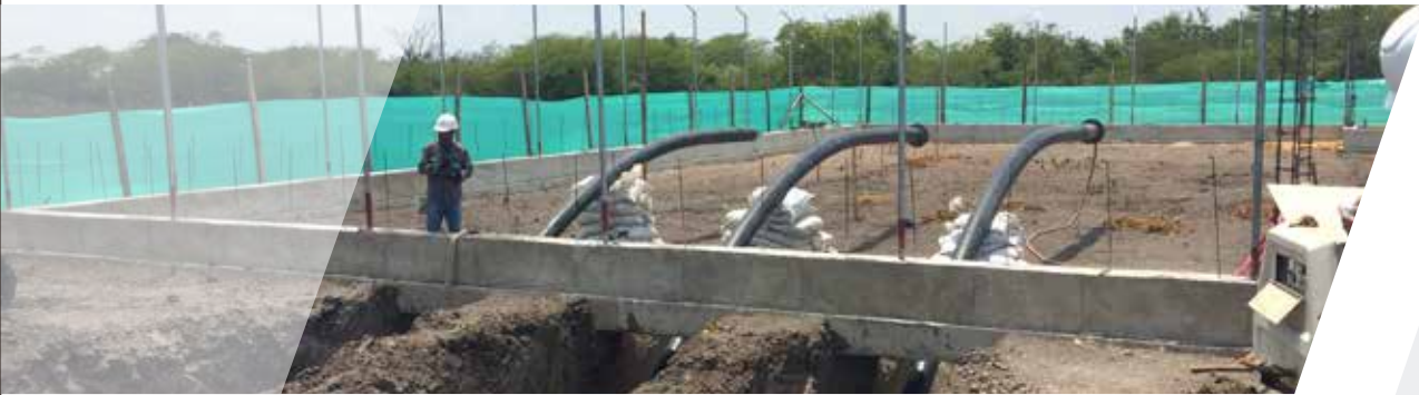
Construcción gasoducto de distribución Interconexión Magdalena - Cesar
